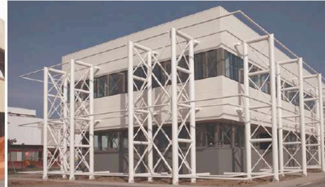
Palazzina Uffici post sisma 2012 ultimazione lavori
